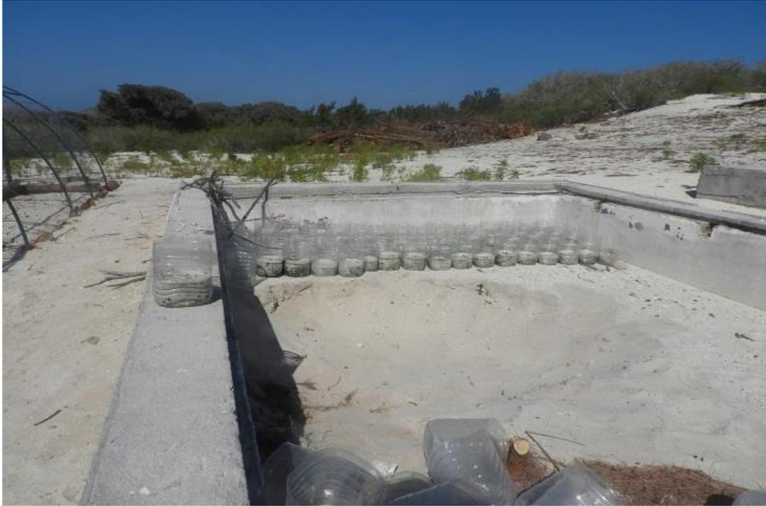
*Figure 1.20 : Cuve de béton faisant office de module de stockage des substrats (module 4). Elle est actuellement comblée sur plus d'un mètre de sable et de graviers coralliens.*
