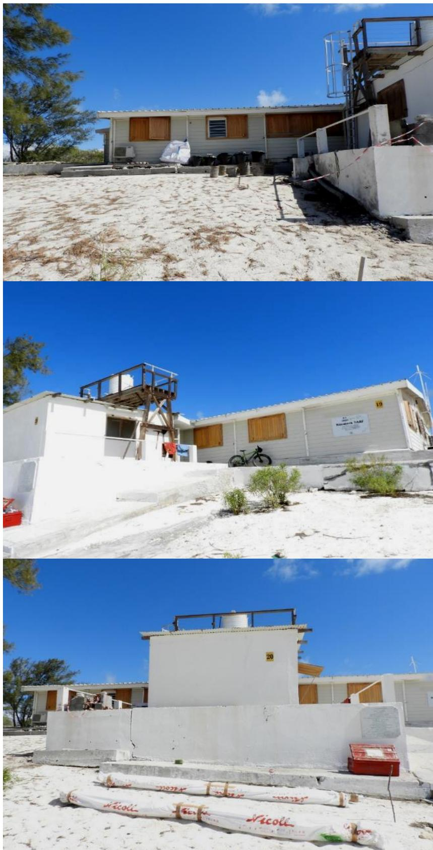
*Figures 1.14 : Façade sud de la station TAAF. Etat initial avant pause des gouttières. Les toitures de la station ainsi que de l'annexe cuisine sont dans un état très convenable. En revanche, les dalles de bétons présentent de nombreuses fissures et des points d'éclatement.*
