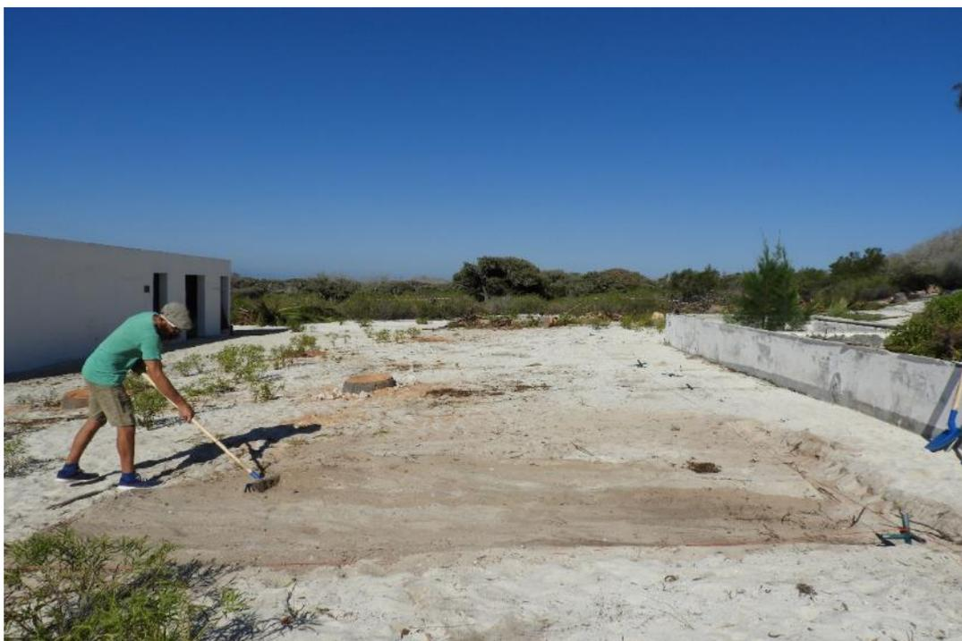
*Figure 1.2 : Terrassement de la zone d'emprise des modules 1 et 2. La surface terrassée est d'environ 86 m<sup>2</sup>.*
