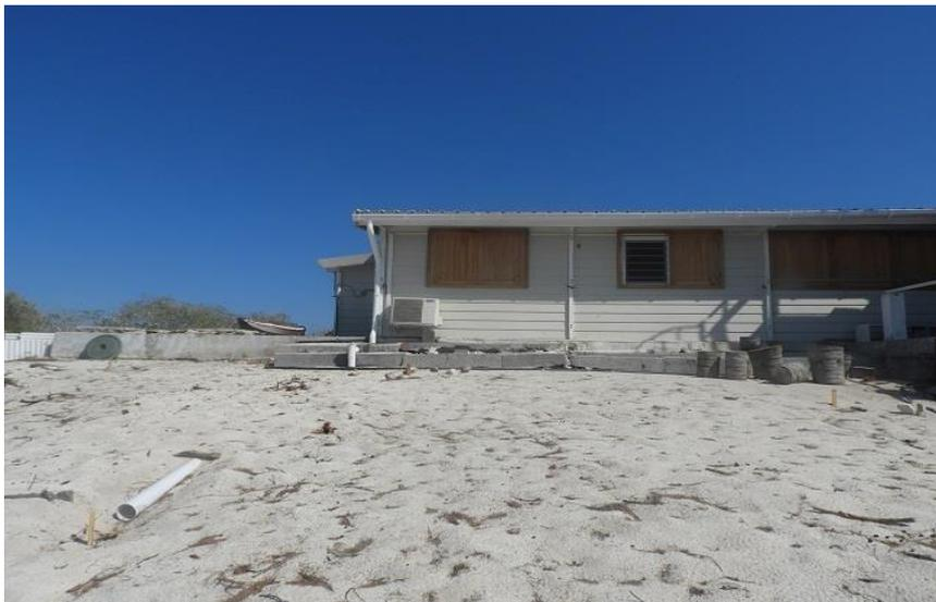
*Figures 1.15 : Façade sud de la station TAAF, aile gauche. Gouttières, saignée et tube de descente. Par défaut de tuyau souple de 50 mm diamètre et de réducteur, le tuyau PVC de 100 mm de diamètre semi enterré (au 1<sup>er</sup> plan) n'a pas encore pu être raccordé à la cuve.*
