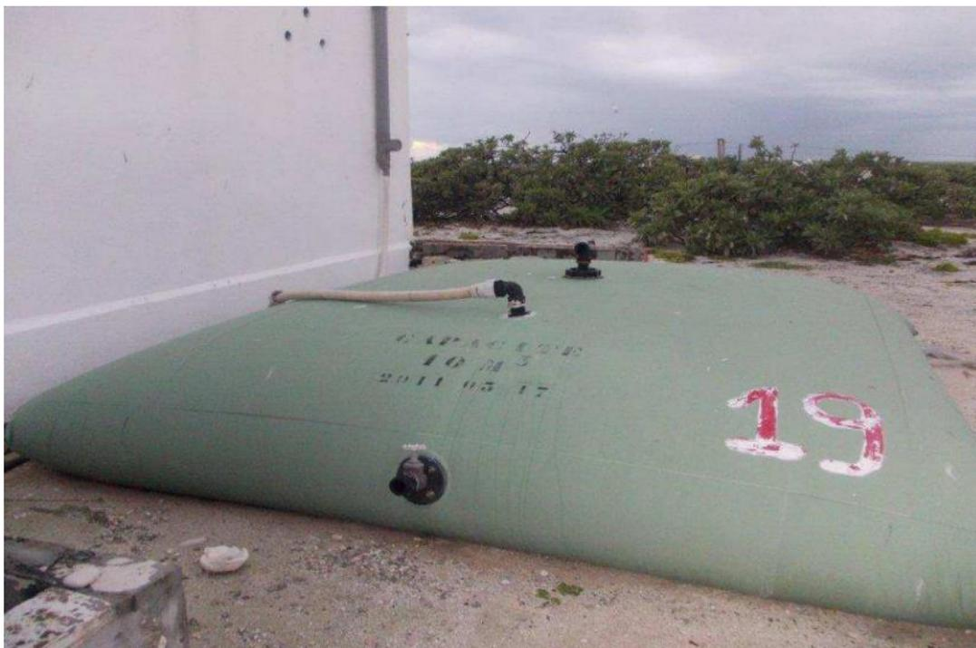
Figure 1.13 : Cuve souple de récupération d'eau de pluie de volume de stockage de 10 m<sup>3</sup> (ici installée à Tromelin).
