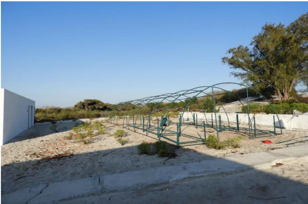
Figure 1.4 : Totalement démontable la structure des deux tunnels est constituée d'une succession de 5 barres cintrées en acier renforcé galvanisé espacées d'1 mètre 50, reliées entre elles par des barres boulonnées à des croix de faitage. Au premier plan, sous le module 1, les pieds des tables montés sans leurs tabliers.
