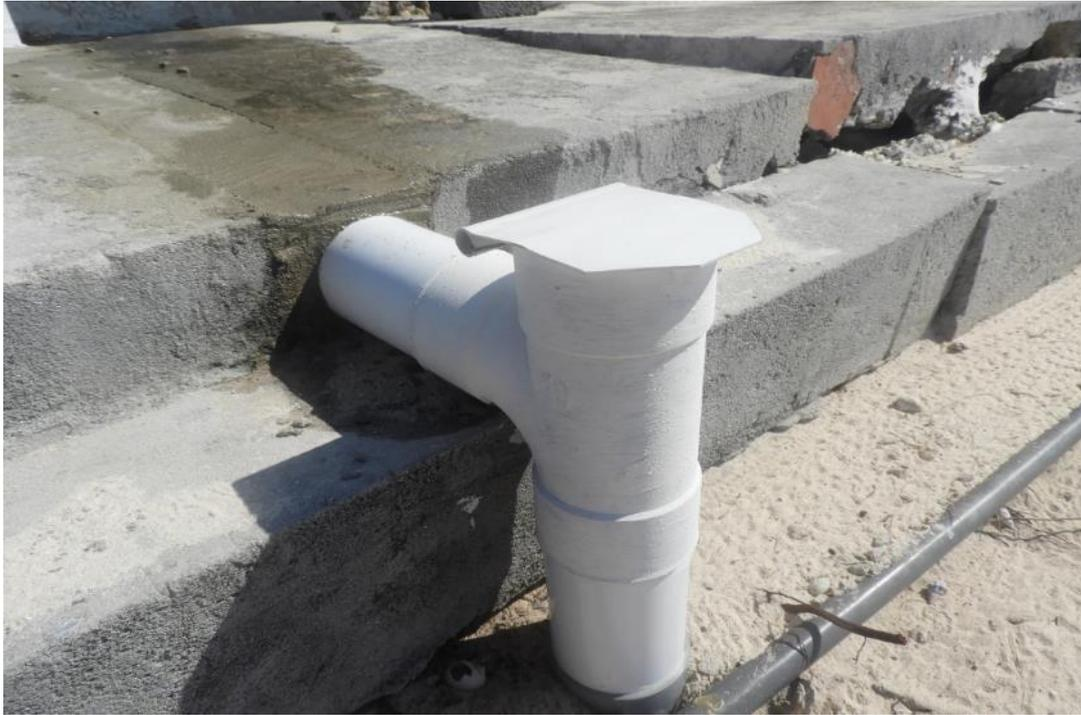
*Figure 1.18 : Clapet de regard et trop plein permettant la décharge, le contrôle et l'entretien des tuyaux d'acheminement d'eau de pluie.*
