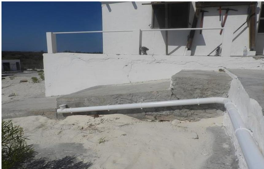
*Figures 1.16 : Façade sud de la station TAAF, aile droite. Gouttières, saignée et tube de descente. Par défaut de tuyau souple de 50 mm diamètre et de réducteur, le tuyau PVC de 100 mm de diamètre semi enterré n'a pas encore pu être raccordé à la cuve.*
