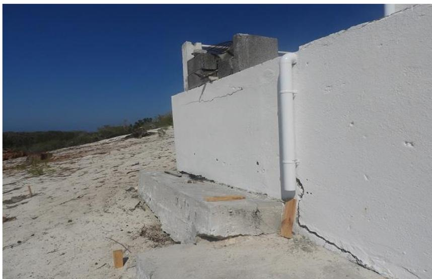
*Figures 1.17 : Façade sud de la station TAAF, annexe cuisine. Gouttières, saignée et tube de descente. Par défaut de tuyau souple de 50 mm diamètre et de réducteur, le tuyau PVC de 100 mm de diamètre semi enterré n'a pas encore pu être raccordé à la cuve.*
