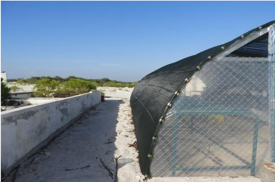
*Figure 1.8 : Clips de maintien du film Polyane et de l'ombrière installés sur les arceaux frontaux du module 1.*
