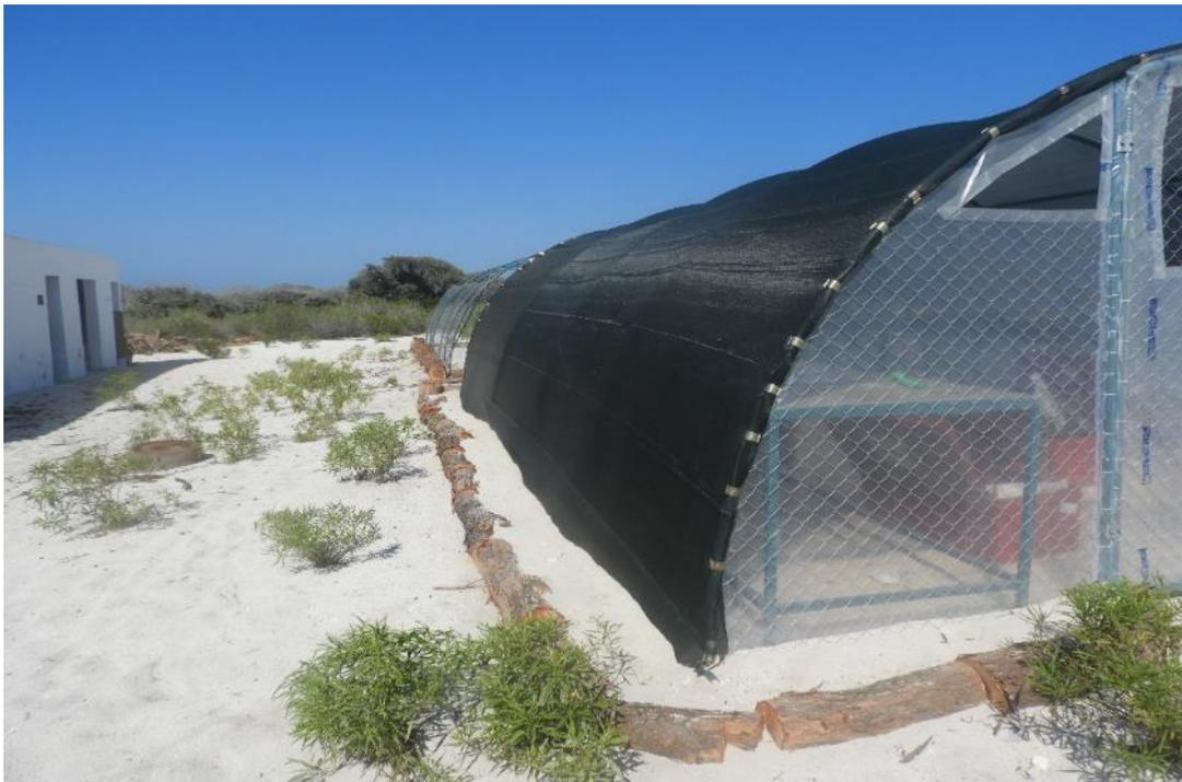
*Figure 1.9 : Bacs de maintien en sable et en rondins de filao stabilisant le terrassement et le sable tout autour du module.*
